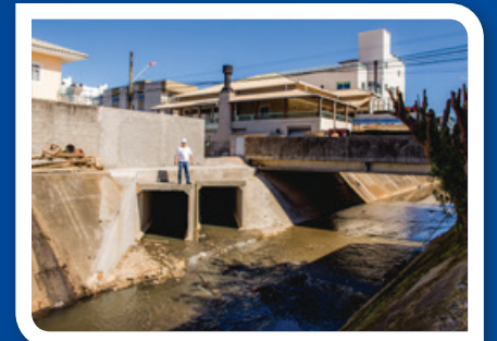
Macro drenagem no antigo Rio da Palha, Ipiranga/Areias.
