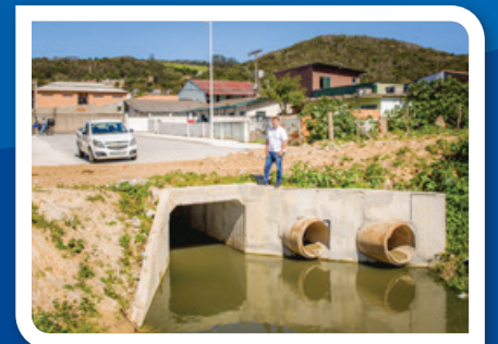
Macro drenagem na João Paulo Gaspar, Ipiranga/Pedregal.
